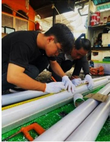
Gambar 5. Proses pengukuran pipa yang akan digunakan
